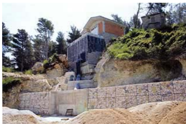
Slika 5. Zahvatna građevina crpne stanice Kunčeva Greda
