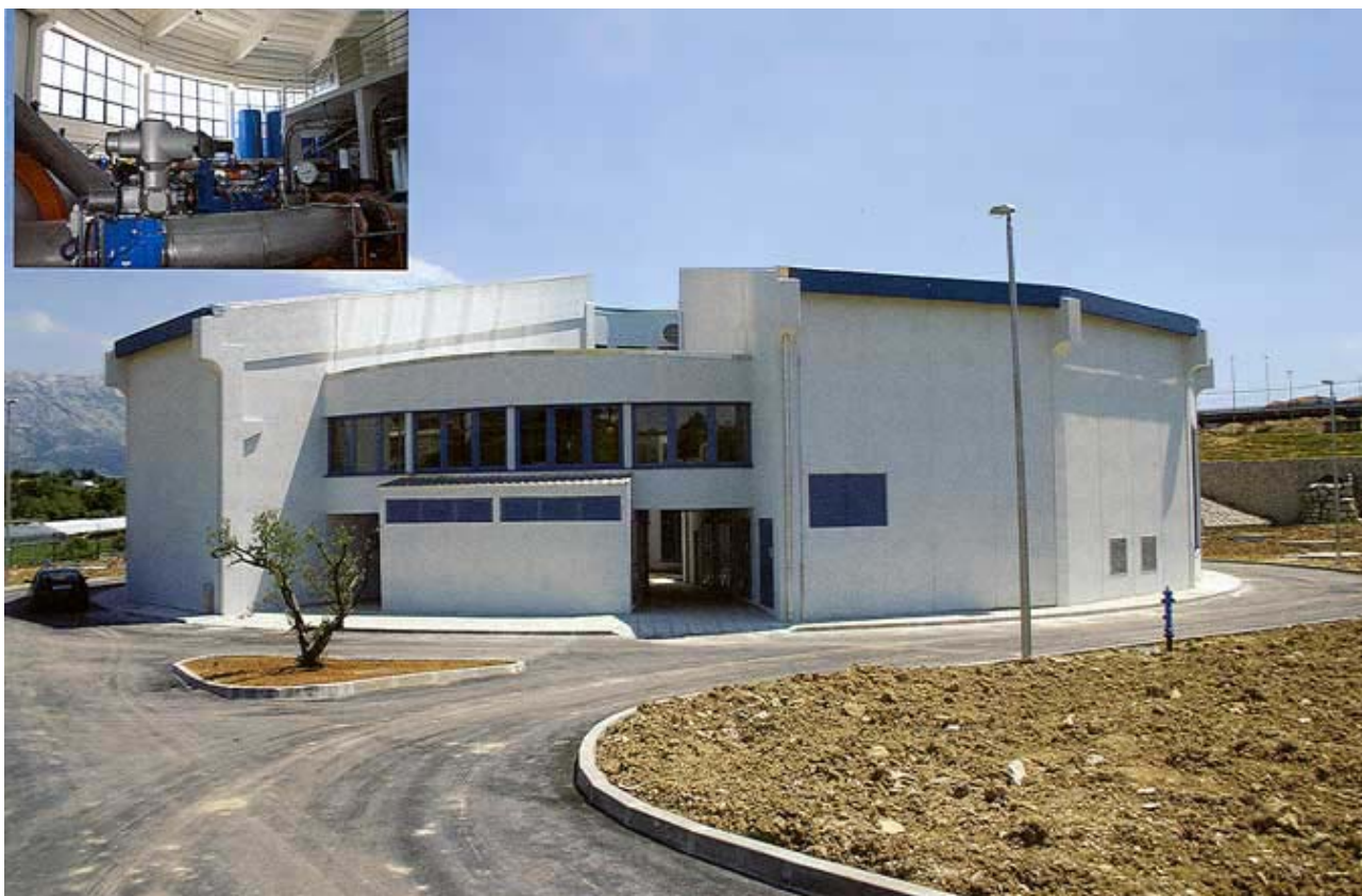
Slika 9. Crpna stanica Ravne Njive
