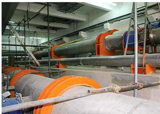
Slika 8. Ugradnja opreme u crpnoj stanici Kunčeva Greda
