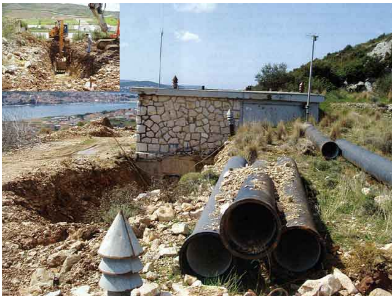
Slika 4. Radovi na rekonstrukciji vodospreme Pantana
