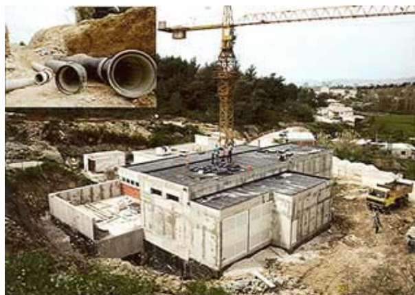
Slika 7. Završna faza radova na crpnoj stanici Kunčeva Greda
